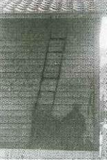
在距爆炸中心地向南约4.4公里的要塞司令部，士兵从屋面上下来时受到热线的直射，光照到部分的煤焦油（涂料）已剥落，仅影子部分留下了黑色。
