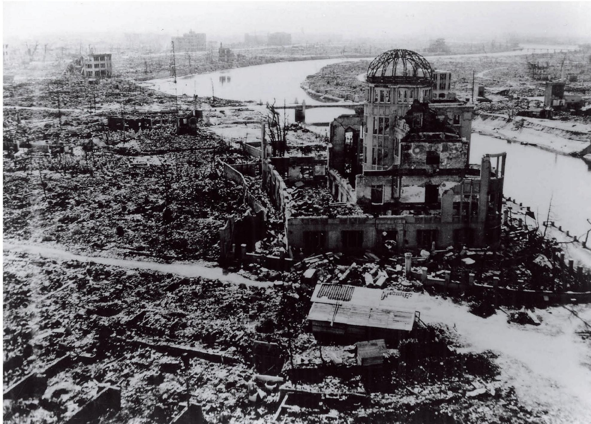
El edificio se colapsó en un instante; el fuego descendió desde el techo y el edificio ardió por completo. Al recibir el impacto de la onda explosiva justo desde arriba, algunas de sus paredes escaparon a la destrucción, para convertirse junto con el armazón de acero de la cúpula, en la tan simbólica silueta.
