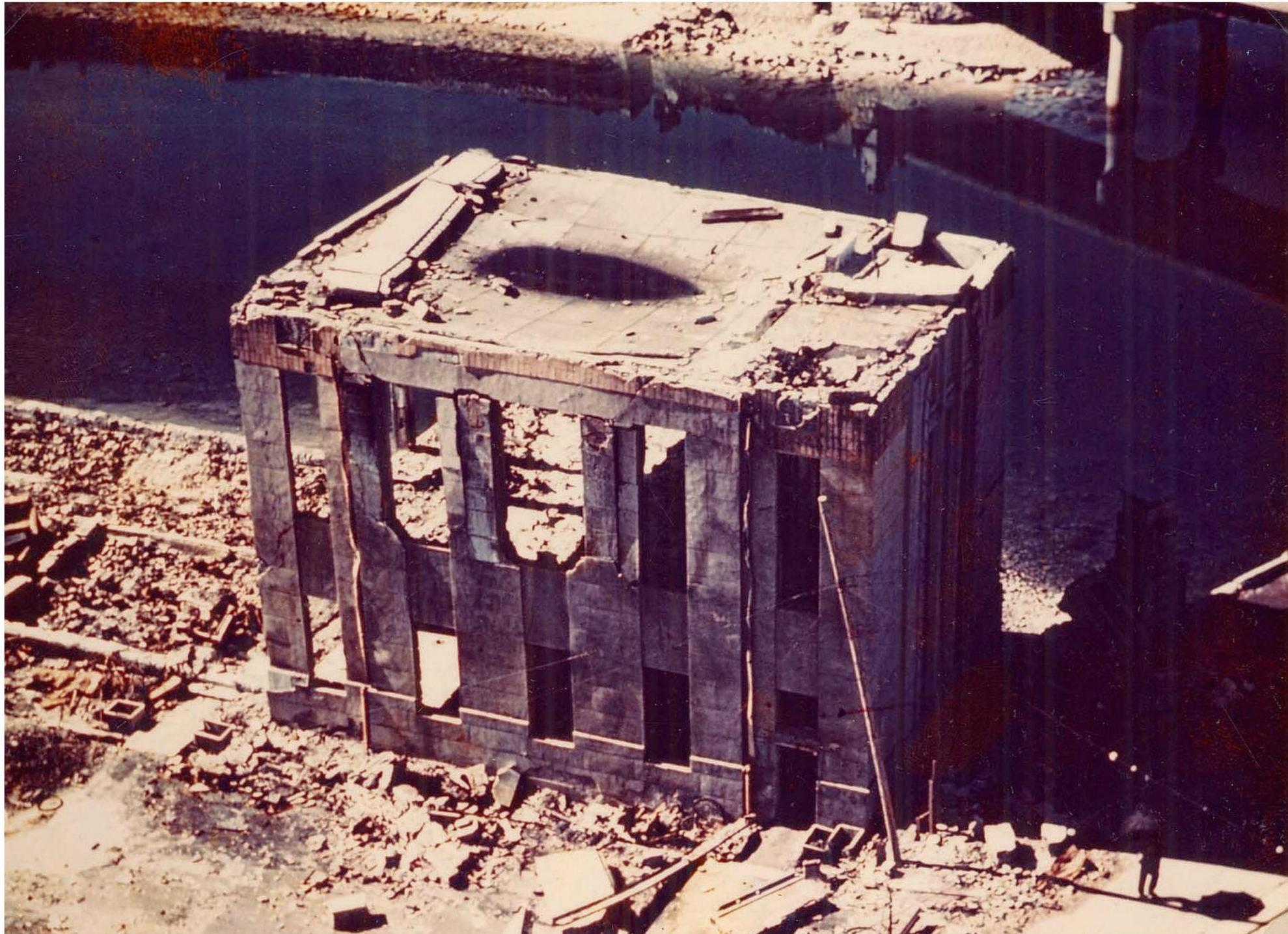
Localizada logo abaixo do centro da explosão, a onda de choque vinda de cima curvou o telhado. A foto também mostra água das chuvas trazidas por um tufão em setembro acumulada sobre o telhado devido à curvatura causada pelo impacto.
