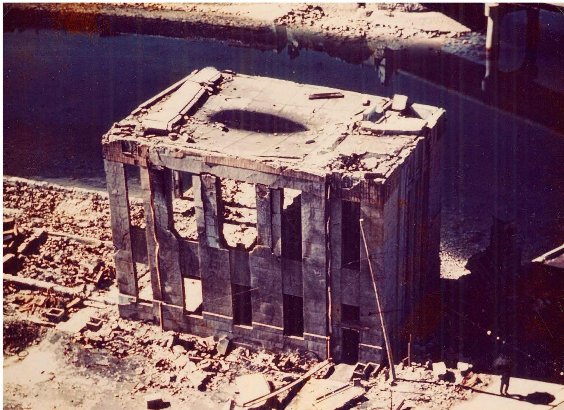
L'edificio della Croce Rossa, posto esattamente sotto la traiettoria dell'esplosione. È stato danneggiato soprattutto sul tetto, dove si è aperto un ampio varco.
