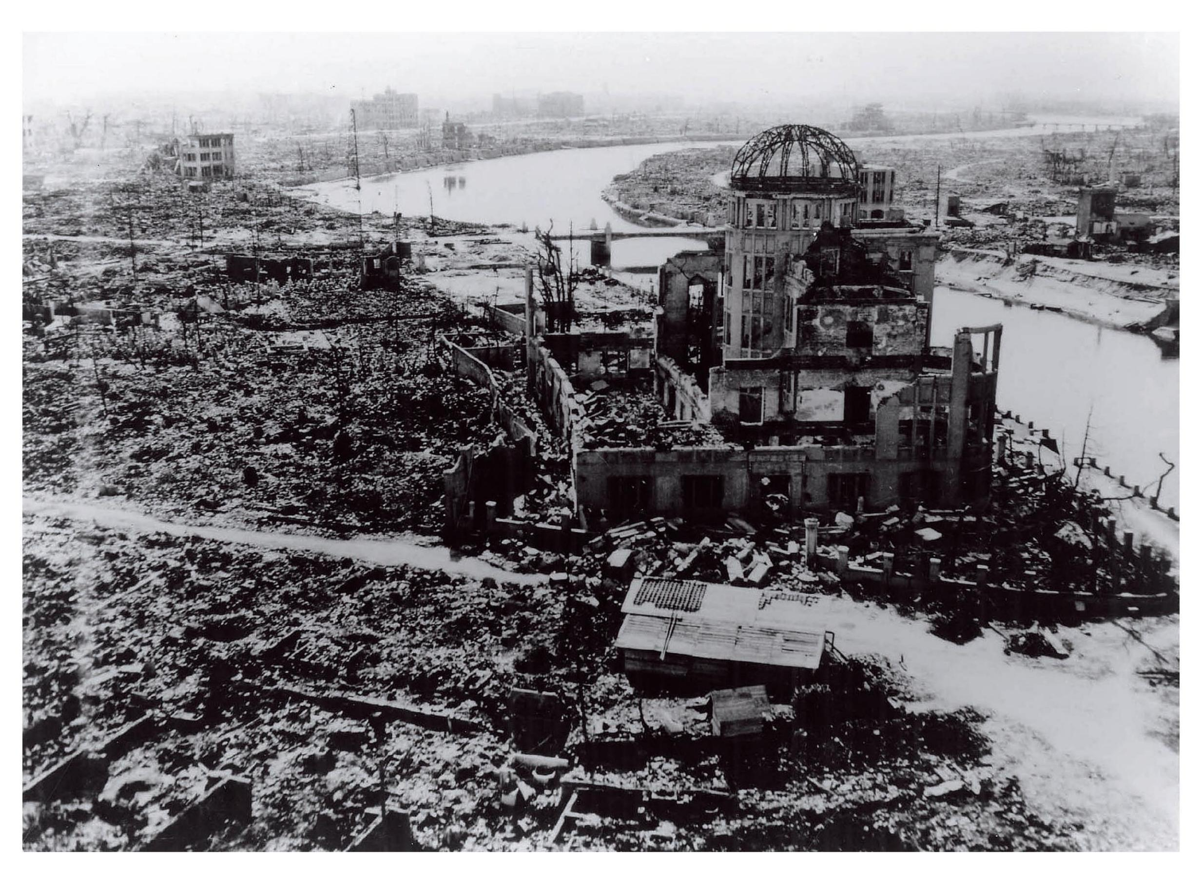
Das Gebäude wurde innerhalb eines Augenblicks zerstört. Aus dem Dach schlugen hohe Flammen und brannten es vollständig aus. Da der Explosionsdruck fast senkrecht von oben auf das Gebäude traf, blieben Teile des Mauerwerks stehen. Zusammen mit dem Gerüst des Kuppeldachs sind sie ewiges Symbol.
