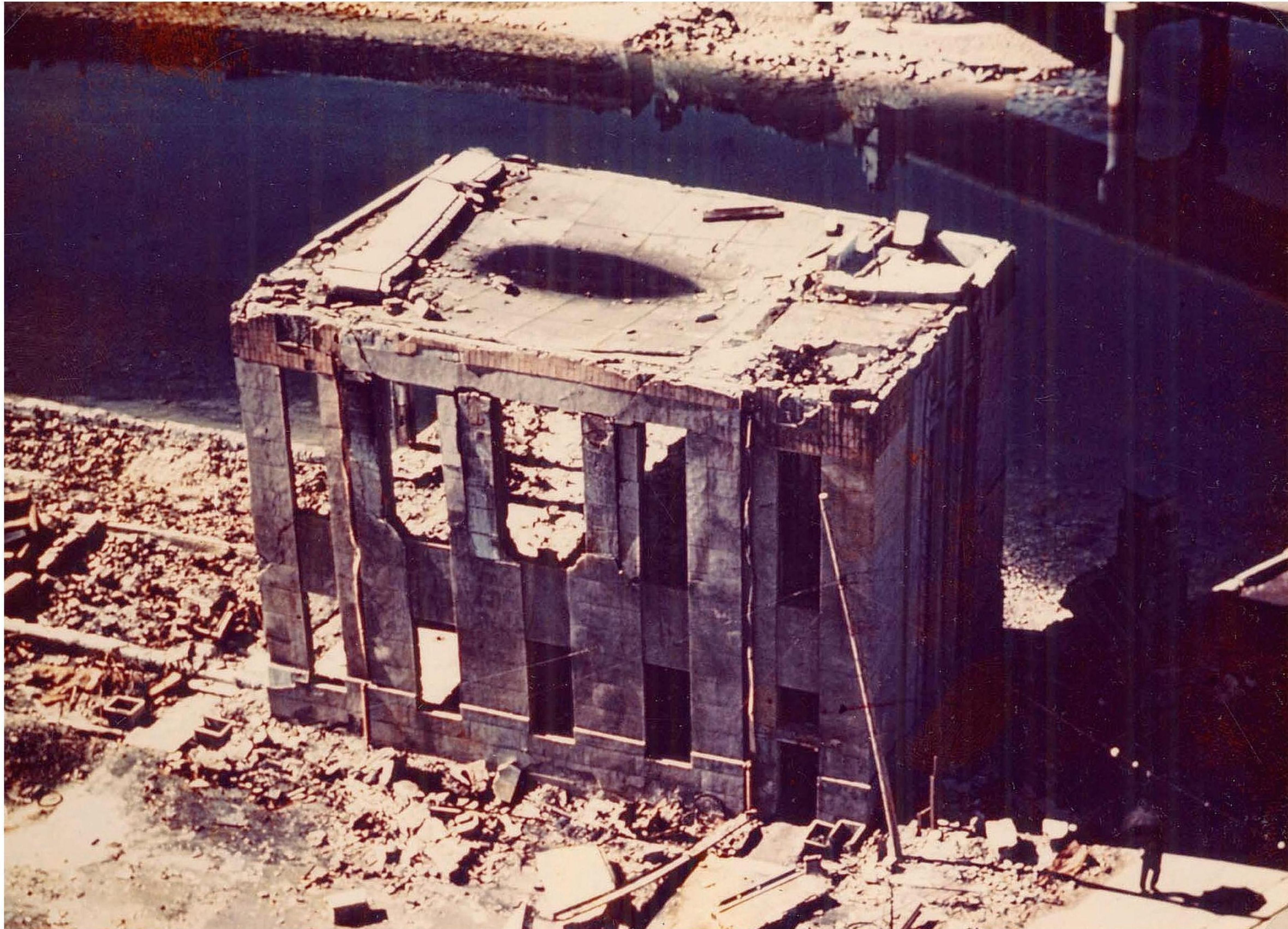
位于爆炸中心正下面，從正面來的爆風使屋頂凹下去，9月份台風來襲時雨水積在屋頂凹面上。
